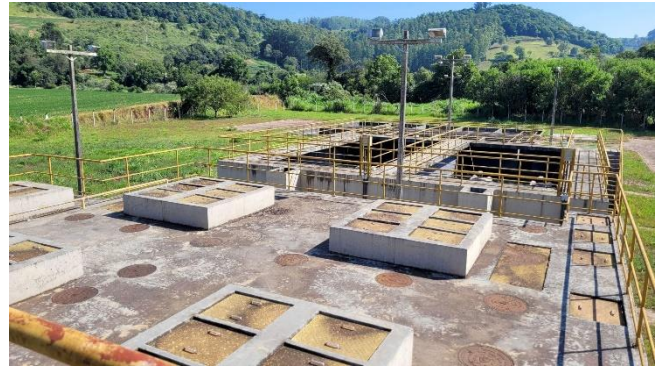
Figura 38: Reatores aeróbios da Estação de Tratamento de Esgoto.
