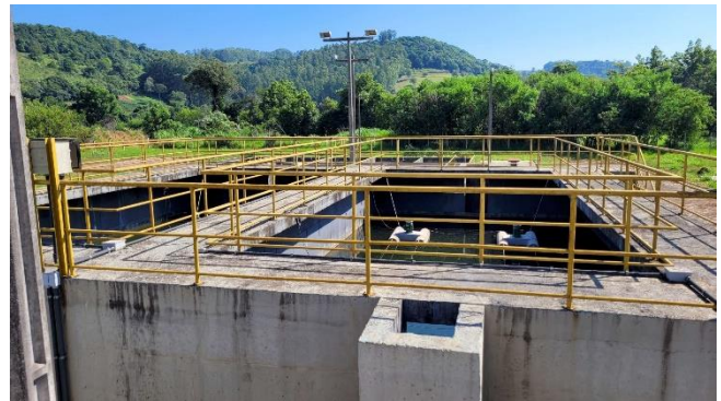
Figura 40: Unidades de secagem de lodo da Estação de Tratamento de Esgoto.
