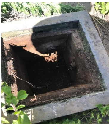
Figura 47: Canos em PVC pintados como se fossem de Ferro Fundido.
