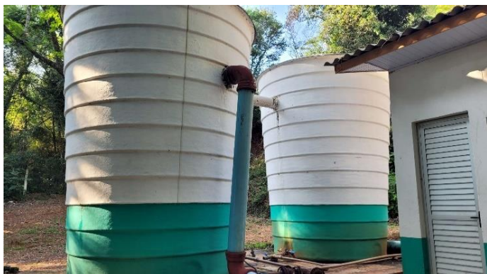
Figura 13: Tanques de contato da ETA
