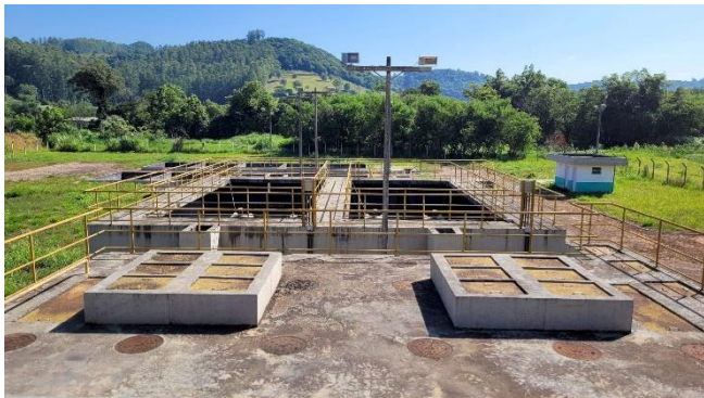
Figura 39: Unidades de decantação da Estação de Tratamento de Esgoto.
