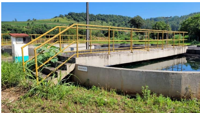
Figura 39: Unidades de decantação da Estação de Tratamento de Esgoto.
