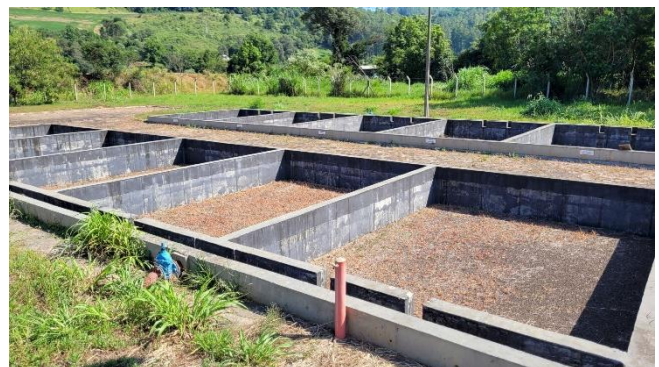
Figura 40: Unidades de secagem de lodo da Estação de Tratamento de Esgoto.
