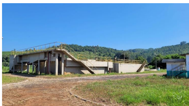
Figura 33: Estação de Tratamento de Esgoto.
