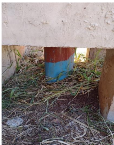
Figura 47: Canos em PVC pintados como se fossem de Ferro Fundido.
