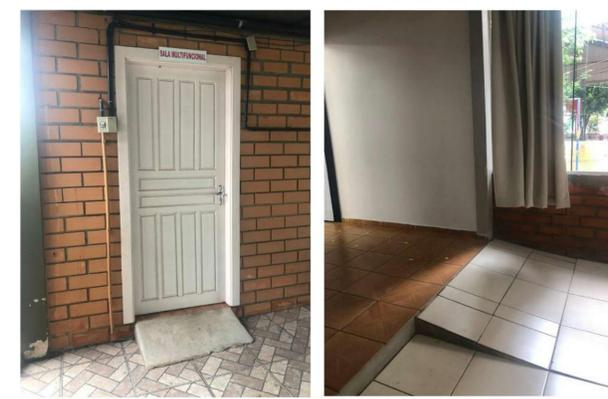
Rampas de acessibilidade a serem reorganizadas, inclinação máxima 5%, aplicação de revestimento cerâmico igual ou semelhante às áreas de circulação adjacentes.
