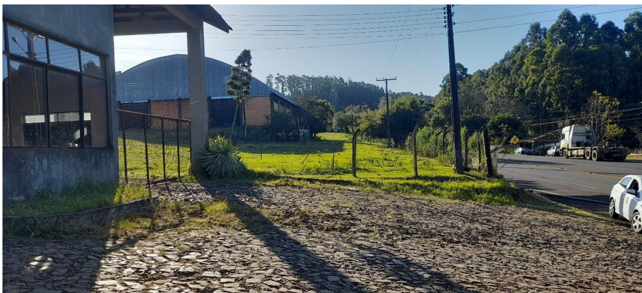
Local, onde será feito o portão de acesso aos barracões
