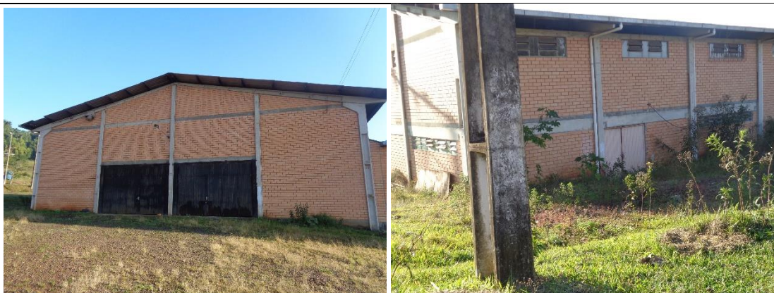
Barracão "A", vista frontal e lateral.
