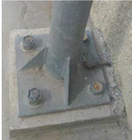
Exemplo modelo de aterramento de poste galvanizado.
